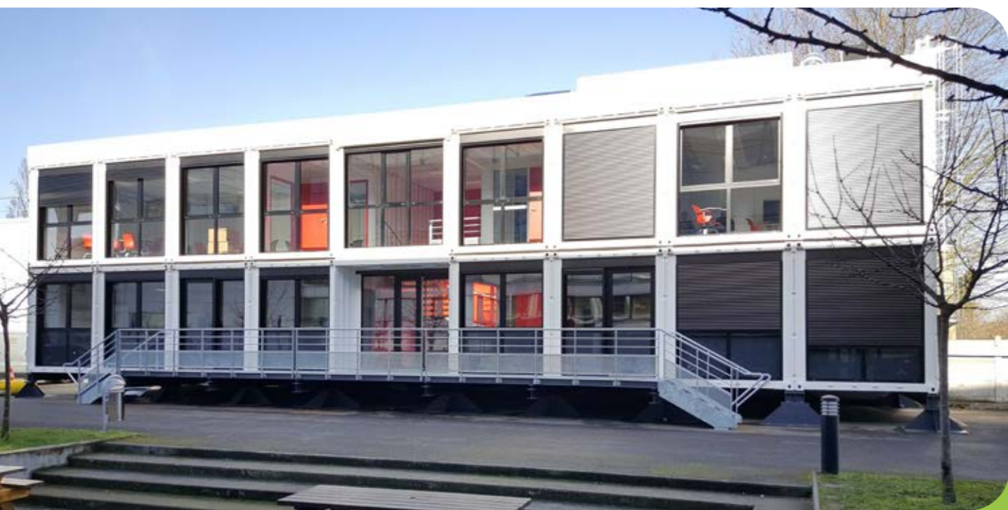
Démonstrateur du bâtiment du futur, Cesi École d'Ingénieurs, campus de Nanterre (92)
