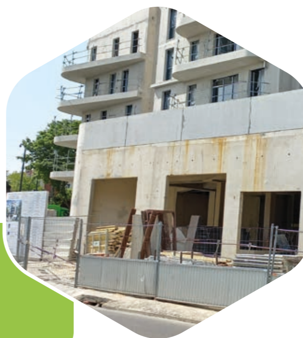
Construction à Rueil-Malmaison (92)
