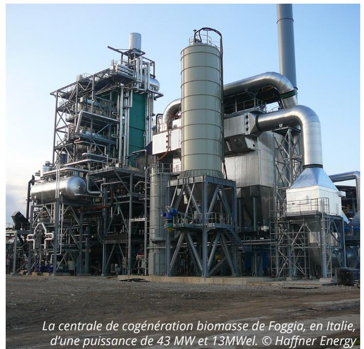
La centrale de cogénération biomasse de Foggia, en Italie, d'une puissance de 43 MW et 13MWel. © Haffner Energy
